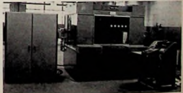
Automatische „wire-wrap” machine.
